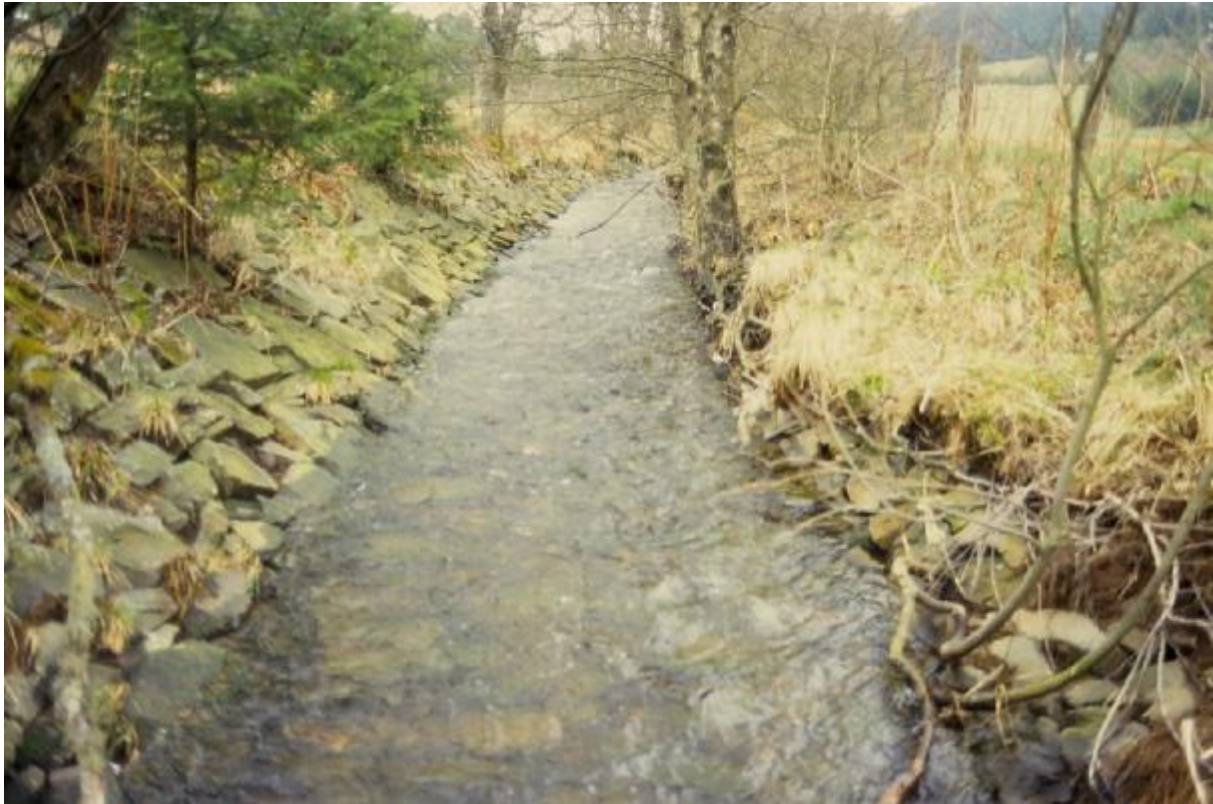
Abb. 7: Der Schwarzbach (Probestelle Nr. 6) mit Sohl- und Uferbefestigung
